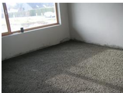
Foto: massetto alleggerito con perle di EPS
