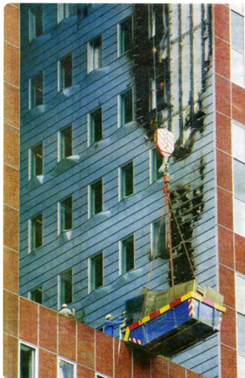
Le rifiniture sono importanti! Nonostante gli avvertimenti del costruttore del tetto, sono state scelte le rifiniture più economiche. Risultato: la struttura in legno ha preso fuoco.
