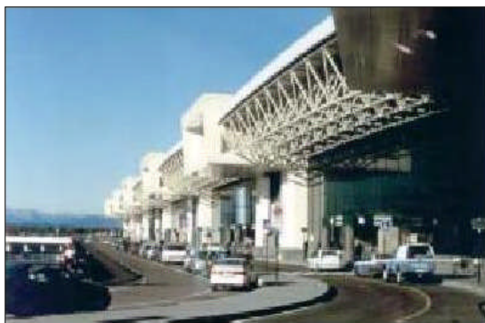
Aeroporto Malpensa (MI) Isolamento copertura piana con XPS
