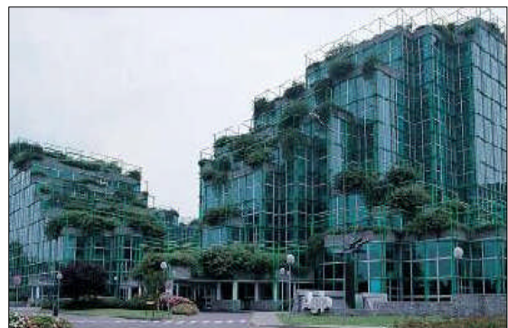
Palazzo uffici – San Donato (MI) Isolamento tetto giardino con XPS
