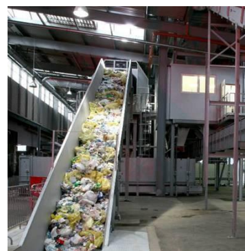
Foto: Impianto di selezione di rifiuti
