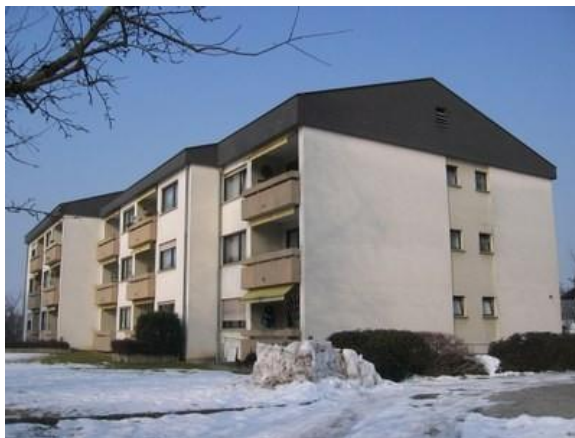
Foto: Edificio residenziale Rankweil-Schleipweg prima dell'intervento di ristrutturazione
