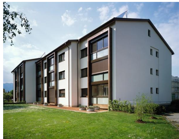
Foto: Edificio residenziale Rankweil-Schleipweg dopo l'intervento di ristrutturazione
