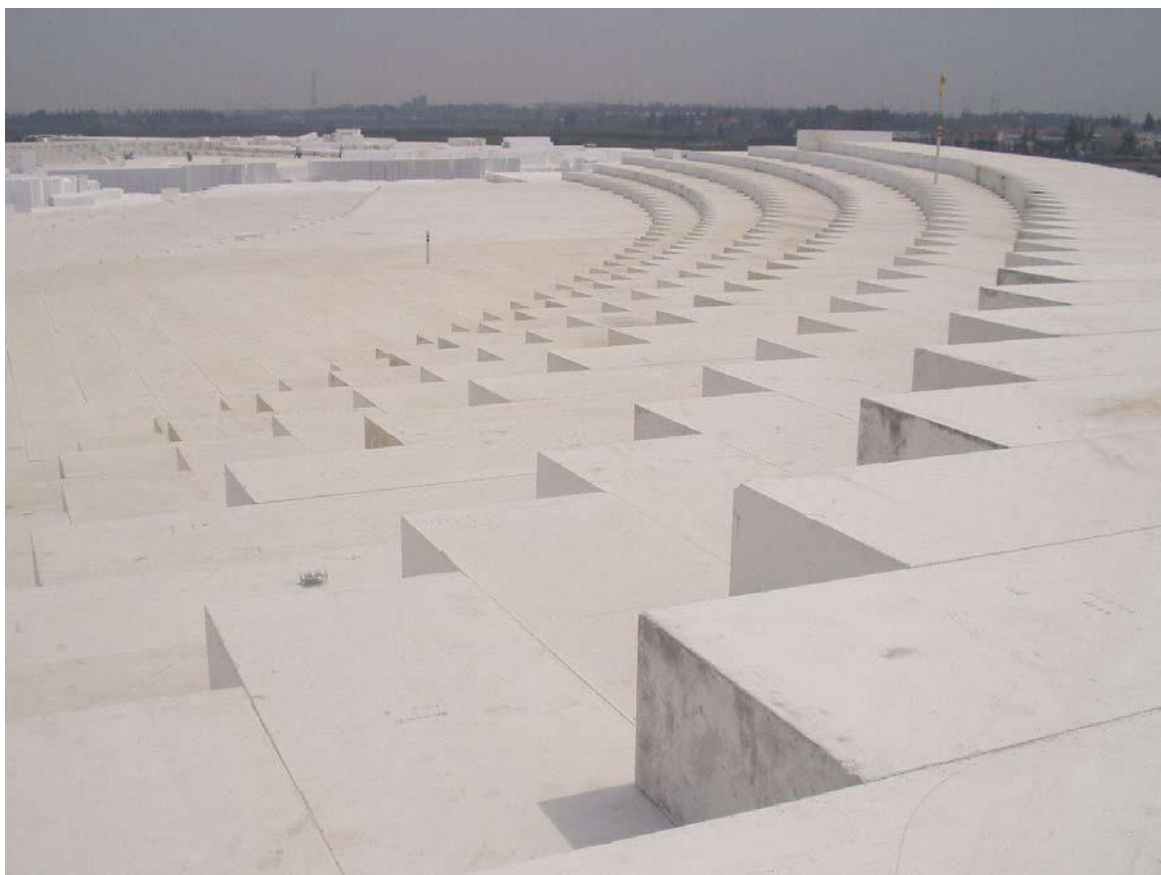
Foto: Tribune del circuito di Formula 1 a Shanghai in costruzione
