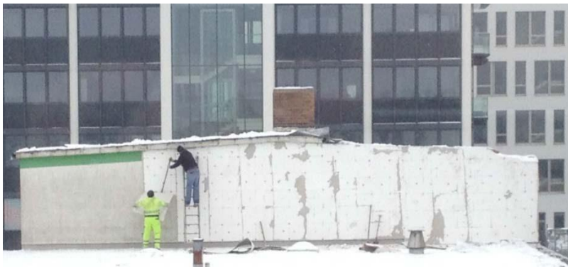
Fotografie: rimozione di un sistema ETICS
