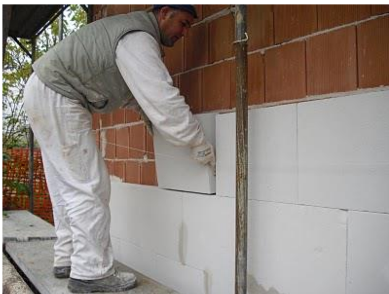
Rivestimento esterno con intonaco sottile su isolante
