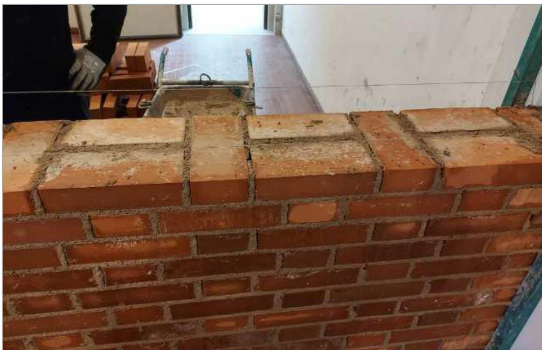
Elementi utilizzati per la realizzazione del muro pesante
