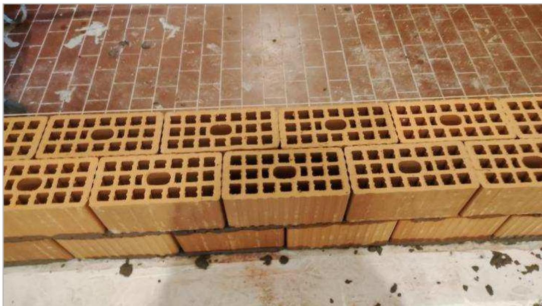
Elementi utilizzati per la realizzazione del muro leggero
