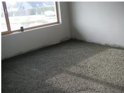
Foto: massetto alleggerito con perle di EPS
