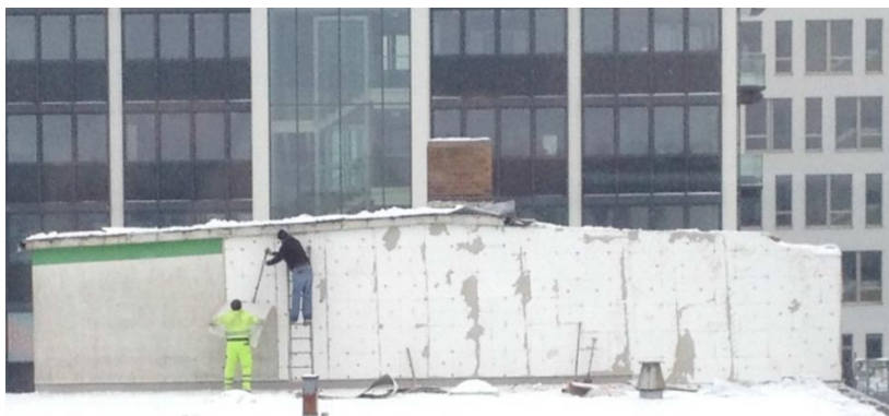
Fotografie: rimozione di un sistema ETICS
