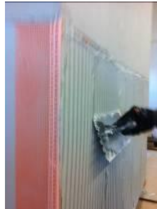
Dettaglio della parte bassa con la corretta posa nella rasatura della rete: si rassa, si immerge la rete e si uniforma la rasatura
