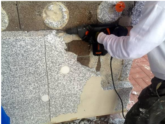
Fasi della rimozione dei pannelli
