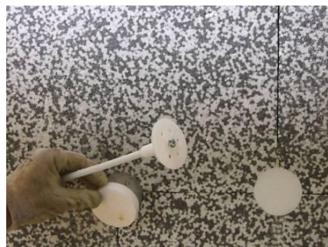
Particolare della posa dei tasselli e della copertura con rondelle in EPS
