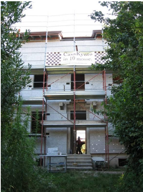
Immagine dell'inizio della posa dei tasselli
