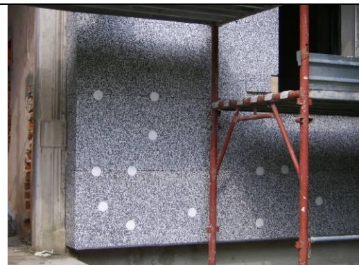
Immagine dell'inizio della posa dei tasselli
