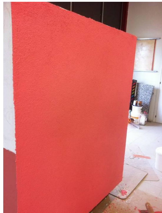
Immagine del manufatto rivestito con intonachino
