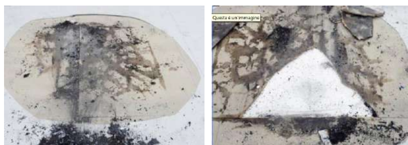
Tetto piano con EPS e rivestimento cementizio sovrastante – Propagazione estremamente limitata dell'incendio sulla superficie del tetto e danni minimi al materiale isolante.
